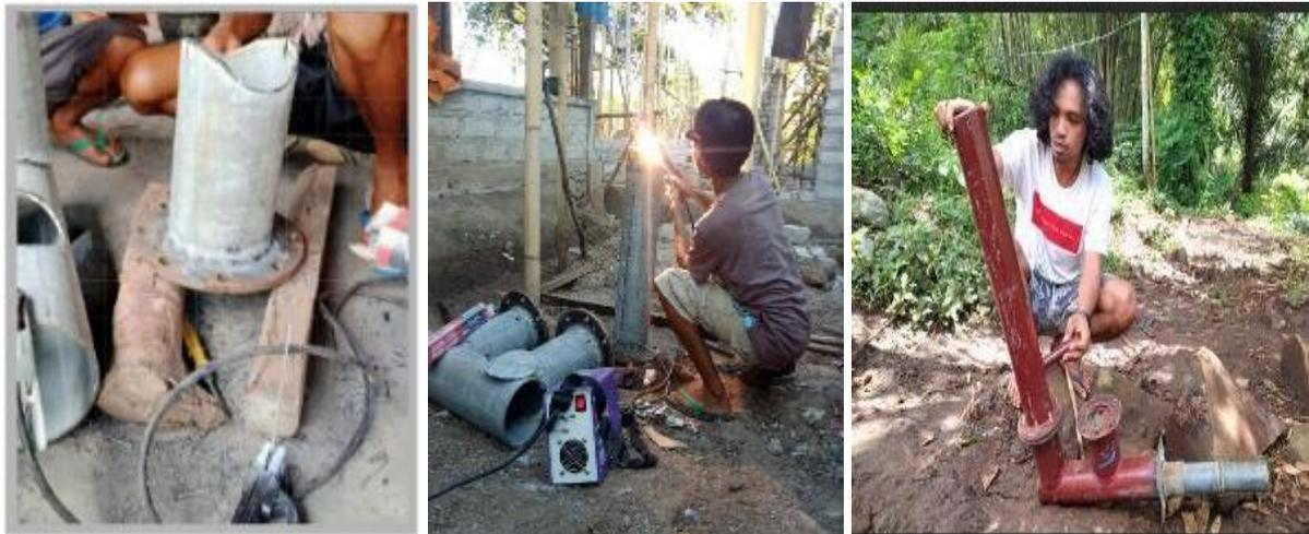
Gambar 5. Proses instalasi pompa hidram
